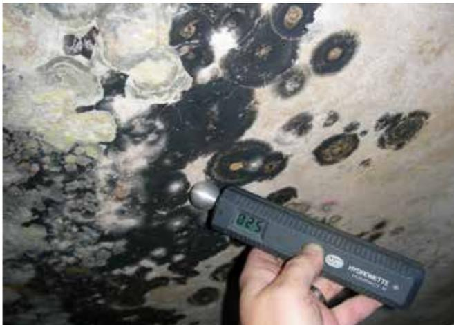
Bild 1–2: Typische Schimmelschäden
