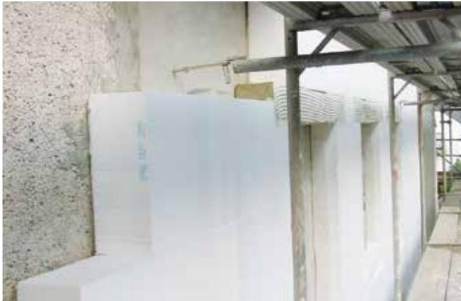
Bild 29: Wärmedämmverbundsystem mit Polystyrol
